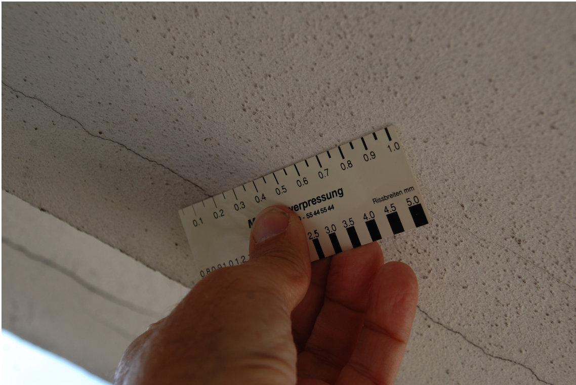
Bild 9 WE Schöler; Rissbreite 0,20 mm
