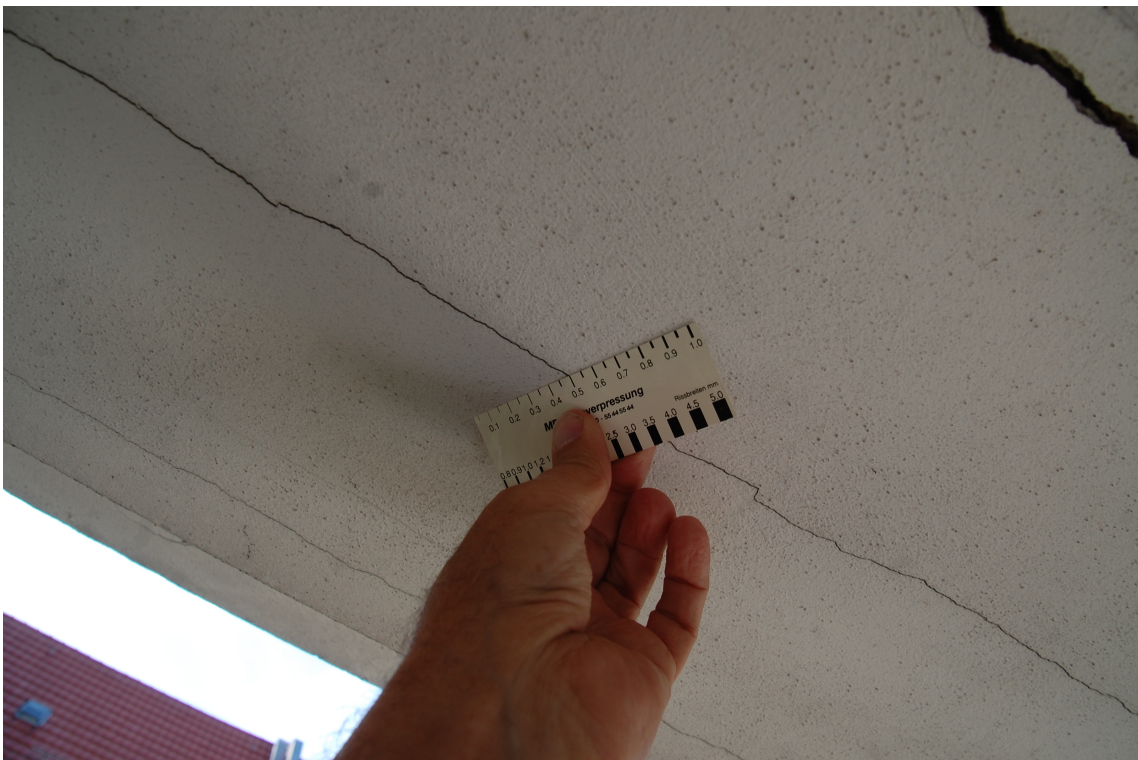
Bild 8 WE Schöler; Rissbreite 0,50 mm
