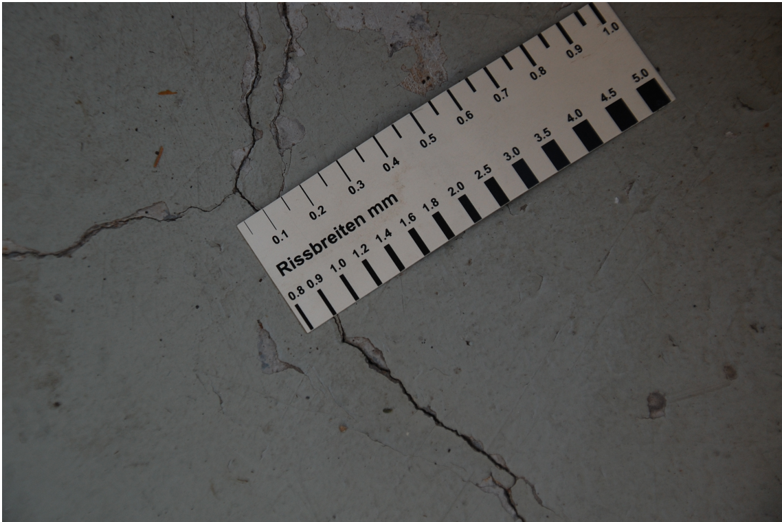
Bild 11 WE Müller – Heinrich; Rissbreiten von 0,1 bis 0,3 mm
