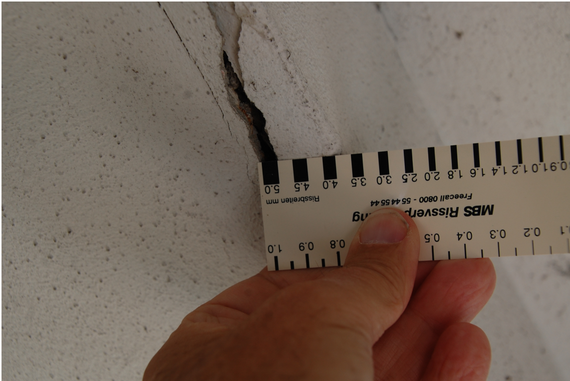
Bild 7 WE Schöler; Rissbreite 5,00 mm mit Hohllagen
